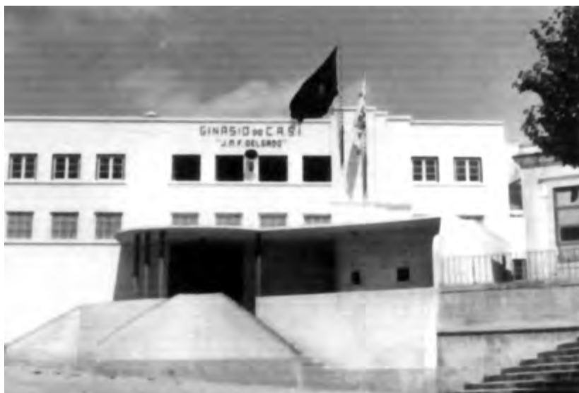
Na construção do Ginásio do CASI foram utilizadas mais de sete toneladas de ferro.
